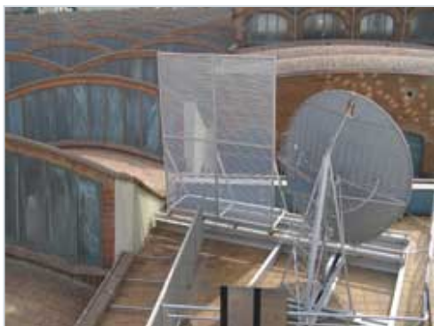
El reflector solar Scheffler está perfectamente integrado en la terraza del edificio modernista del Museo de la Ciencia y la Técnica de Terrassa.
